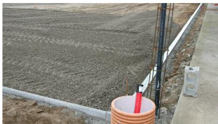
Capas de firme para o futuro terreo de xogo.
