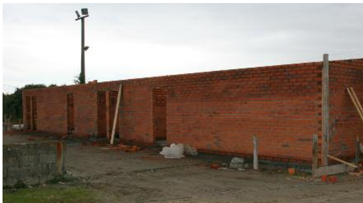
Vista dos novos vestiarios.
