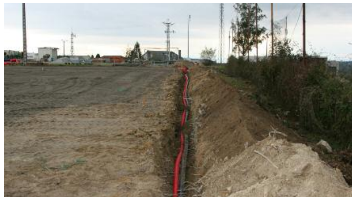
Instalación dos sistemas de drenaxe e regadío.
